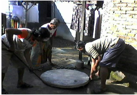
Gambar 3. Pembuatan Sumur Resapan
