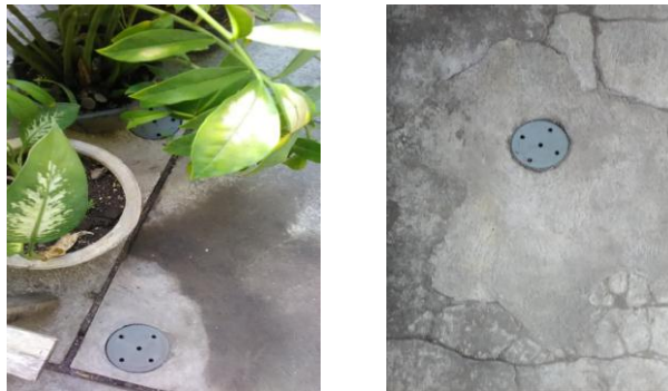
Gambar 4. Pembuatan biopori di rumah warga
