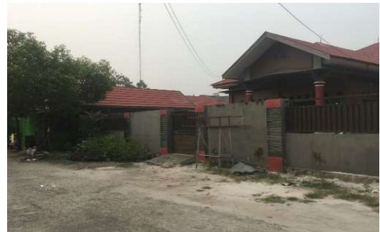
Gambar 8. Kondisi eksisting halaman rumah yang kosong Perumahan Jalan Bandeng II (Sumber: Dokumentasi Tim Pengabdian FT-UPR, 2019)
