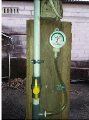
1. Untuk manometer analog, bila jarum ada di titik terendah atau hanya satu strip, maka gas jangan di gunakan, kompor jangan dinyalakan.
