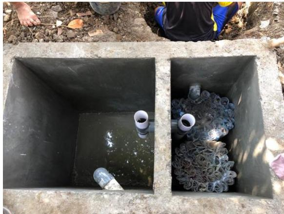
**Gambar 4.** Bagian dalam tangki septik dan tangki filtrasi
