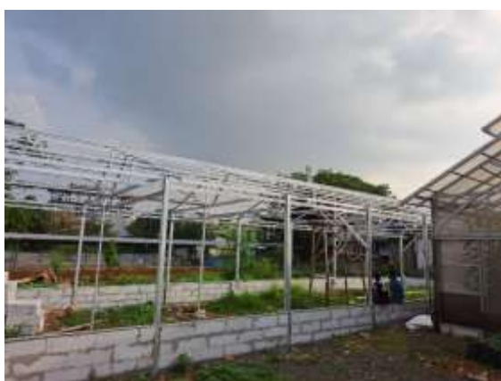
Gambar 3 Pembangunan Green House Kedua
