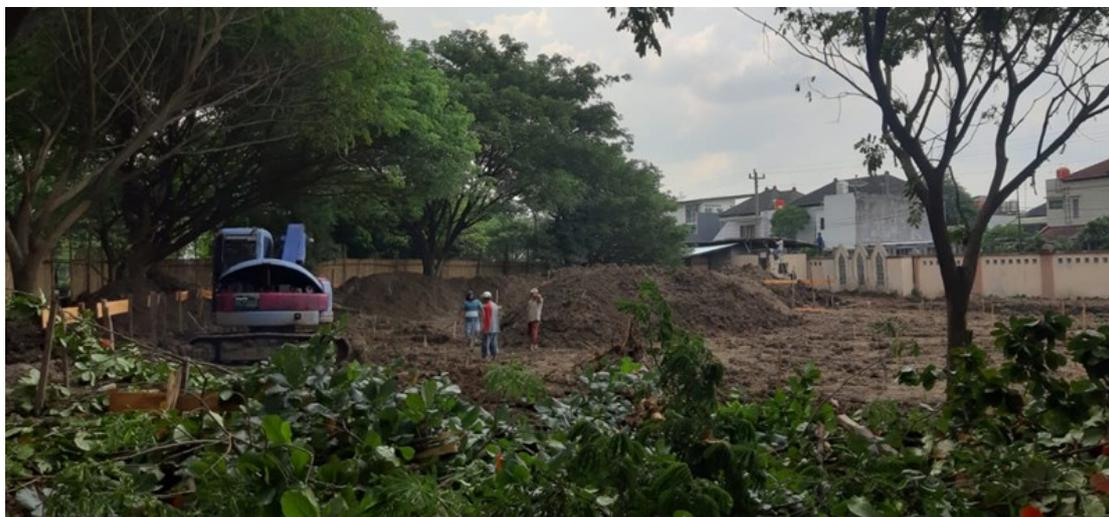
Gambar 4. Kondisi Lapangan Eksisting (Berupa Urugan Tanah Lunak dari Proyek Lain)
