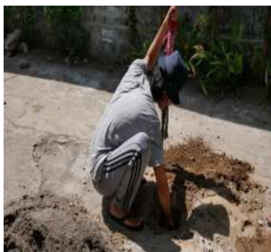
Gambar 2. Kondisi saat pembuatan lubang resapan biopori di Perum Barito Jalan Beo II, Desa Gonilan, Kecamatan Kartasura, Kabupaten Sukoharjo.
