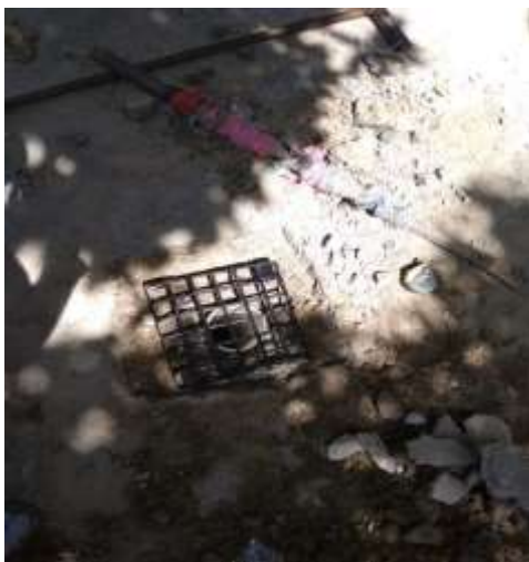
Gambar 3. Dari gambar yang ada di sebelah kiri merupakan tahap pelubangan pada pipa. Dan gambar yang ada di sebelah kanan adalah gambar lubang biopori dalam tahap penyelesaian.
