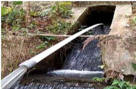
**Gambar 6.** Pipa pesat yang mengalirkan air dari bak penampungan
