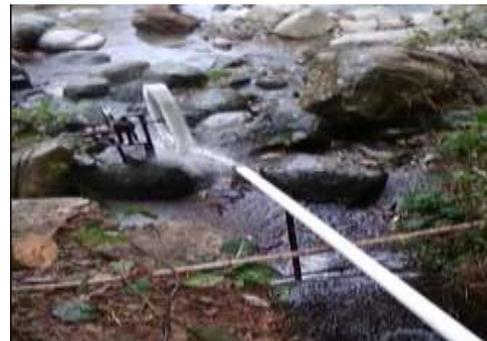
**Gambar 7.** Aliran air dari pipa pesat untuk memutar turbin
